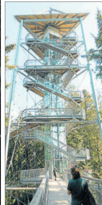
Macht Eindruck: der Skywalk Allgäu mit gläsernem Aufzug (Bild rechts). Rund 500 Tonnen Stahl wurden für den 540 Meter langen Weg durch die Baumwipfel verbaut. FOTOS: SPERLICH
